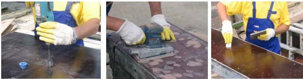
Rys. 1. Naprawianie powierzchni sklejki [www.budoserwis.pl]
