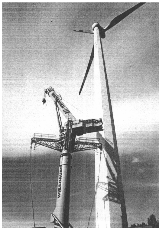
Rys.1. Widok wieży wiatrowej o wysokości 100m wykonanej z drewna
