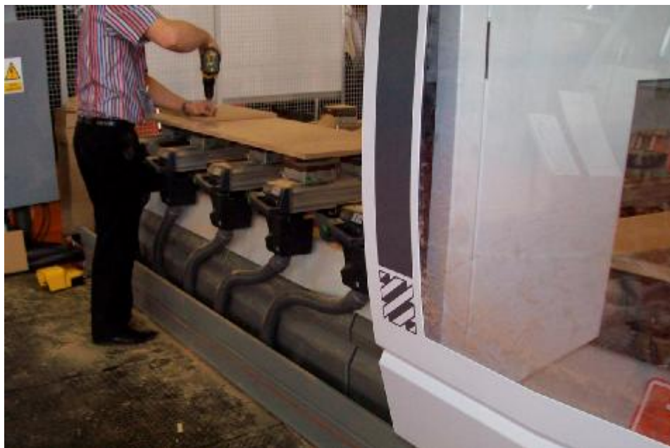
Ryc.11. Zapylenie centrum obróbczego i jego okolicy
