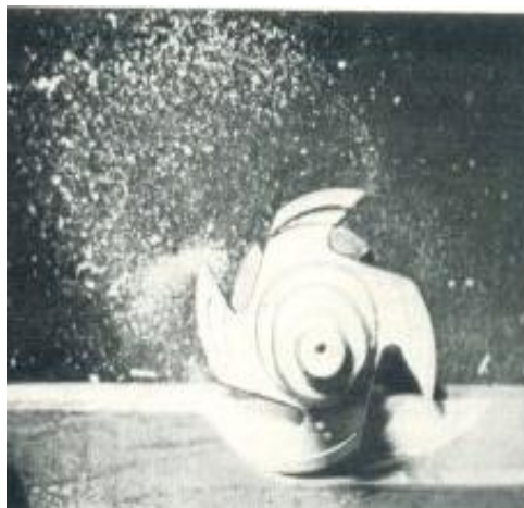
Ryc.13. Rozproszenie wiórów w wyniku odrzucenia przez ostrze obracającego się freza (Barz 1967)
