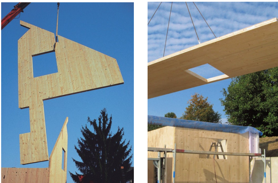
Rys. 5. Elementy wielkowymiarowe wykonane z LENO w trakcie montażu (2)
