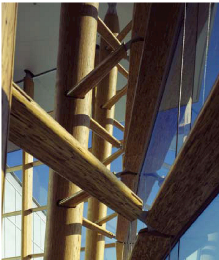
Rys. 6. Elementy z Parallamu stanowiące konstrukcję fasady centrum handlowo-biurowego w Surrey (Kanada) (2)
