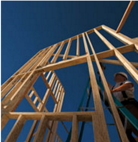
Rys. 7. Szkielet ściany z Intrallamu LSL (5)
