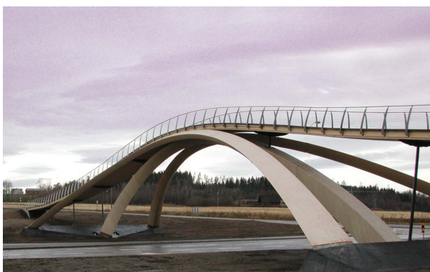
Rys. 3. Most wg. projektu Leonarda da Vinci z 1503 r wykonany z tarcicy warstwowo-klejonej (9)
