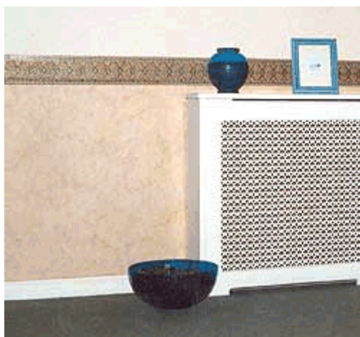
Rys. 12. Obudowa grzejnika z MDF z wykorzystaniem płyty perforowanej
