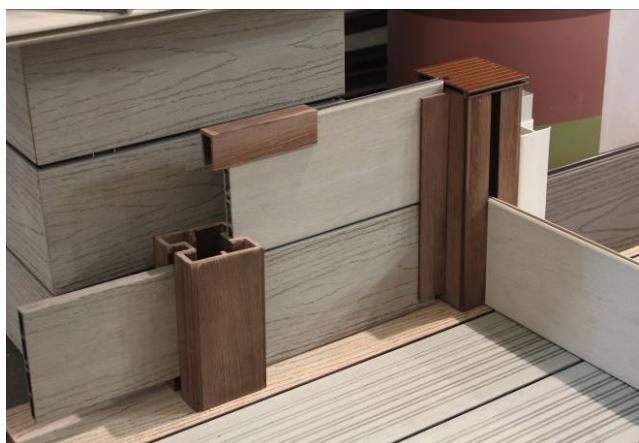
Rys. 11. Przykładowe rozwiązanie konstrukcyjne z wykorzystaniem profili z kompozytów WPC (62) (fot. G. Kowaluk)
