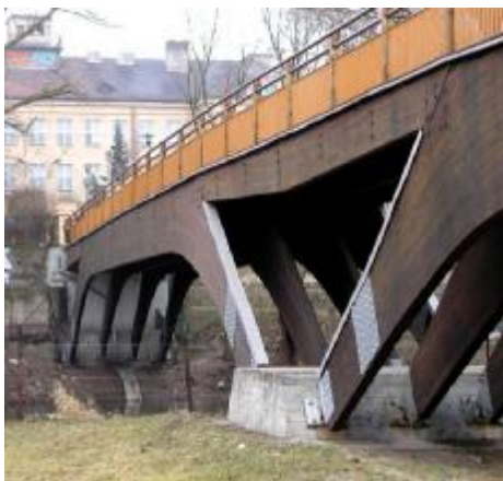
Rys. 12. Kładka dla pieszych w Brodnicy z glulamem, konstrukcja wykonana przez ANDREWEX Sp. z o.o. (6).
