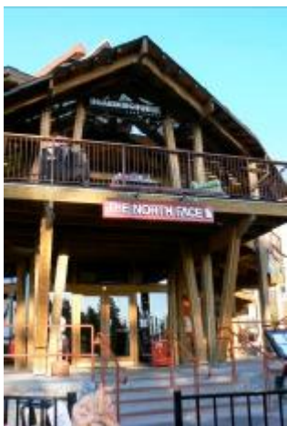
Rys. 8. Dom handlowy w South Lake Tahoe (Kalifornia, USA) o konstrukcji wykonanej z parallamu (fot. P. Borysiuk)
