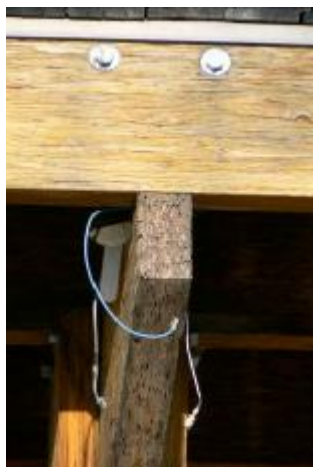
Rys. 8. Dom handlowy w South Lake Tahoe (Kalifornia, USA) o konstrukcji wykonanej z parallamu (fot. P. Borysiuk)
