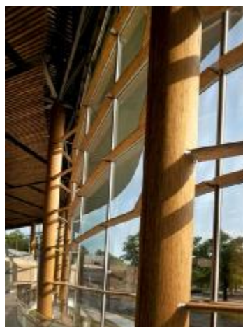
Rys. 9. Słupy i elementy z parallamu w konstrukcji fasady Arena Stage Theatre (Waszyngton, USA), obiekt wybudowany w 2010 r. (14).
