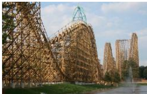
Rys. 6. Konstrukcja rollercoastera El Toro – New Jersey (USA) wykonana z LVL, ukończona w 2005 r. (dane konstrukcji: wysokość – 55 m, długość trasy – 1300 m, prędkość maksymalna wagoników – 110 km/h) (19).
