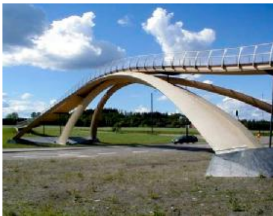
Rys. 13. Kładka dla pieszych nad autostradą w Norwegii według projektu Leonarda da Vinci, wykonana w glulamie (długość mostu – 108 m, rozpiętość podpór – 40 m, wysokość – 10 m) (5).
