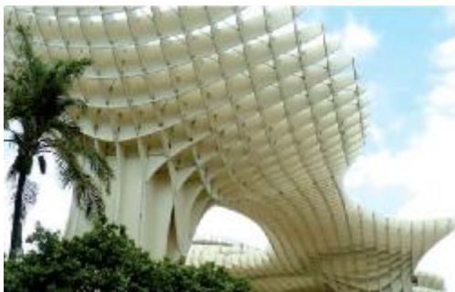
Rys. 5. Metropol Parasol – zabudowa centrum Seville (Hiszpania) wykonana z LVL, ukończona w 2011 r. (wymiar konstrukcji: długość – 150 m, szerokość – 70 m, wysokość – 28 m, powierzchnia – 11000 m 2 ) (8).
